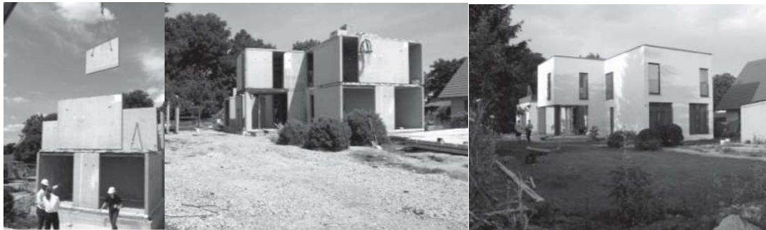
Foto 5. Hoone karkassi montaaž (vasakul); hoone karkass monteerituna (keskel); valmis hoone (paremal) 50
