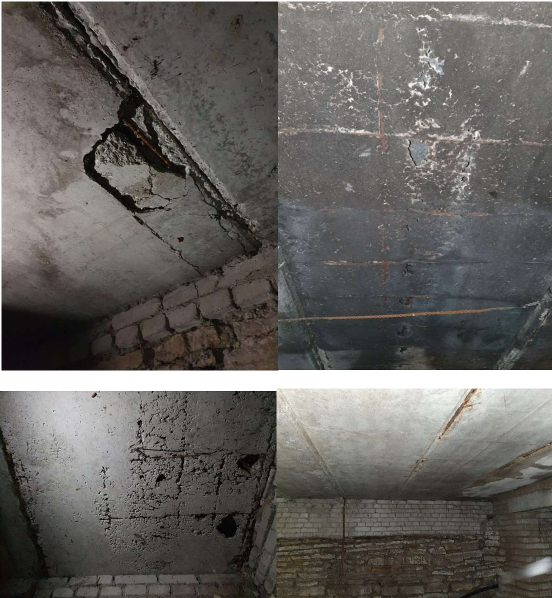
Foto 24. Keldrikorruse laes asuvad raudbetoonist õõnespaneelid ja nende altpoolt visuaalselt eristatavad kahjustused.
