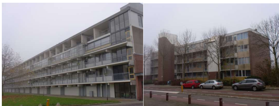
Foto 8. Alles jäetud ning renoveeritud hooneosa (vasakul); demoneeritud raudbetoonpaneelidest rajatud korteralamu (paremal) 51
