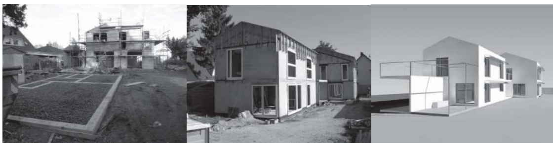
Foto 6. Hoone karkassi montaaž (vasakul); hoone karkass monteerituna (keskel); valmis hoone animatsioon (paremal) 50
