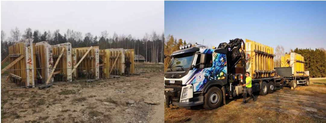
Foto 11. Kilpide ladustamine objektil (vasakul), kilpide transport (paremal) 52
