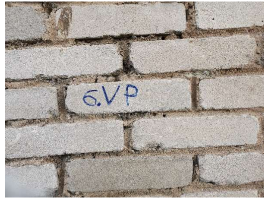
Foto 21. Lähifotod Keskpuiestee 43 silikaatkividest müüritise üldisest seisundist
