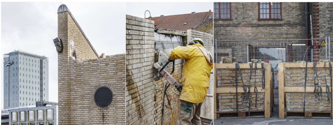
Foto 1. Carsberg-i õllekoda (vasakul); tellisvoodri lahti lõikamine (keskel); objektile ladustatud tellisvoodri plokid (paremal) 48
