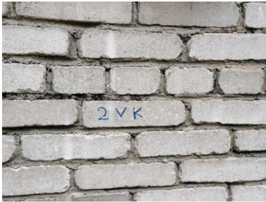
Foto 21. Lähifotod Keskpuiestee 43 silikaatkividest müüritise üldisest seisundist
