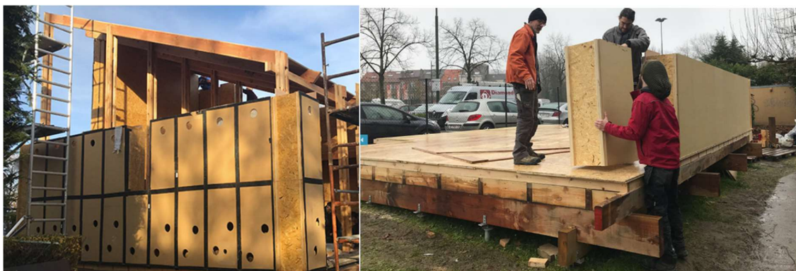
Foto 16. BRIC hoone skelett (vasakul); BRIC hoone seinaelementide montaaž (paremal) 58
