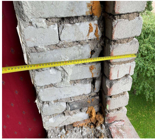
Foto 18. Välissein demonteeritud avatäite kohast
