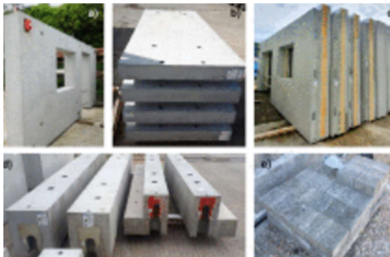
Foto 14. Projektis kasutatud monteeritavast betoonist kandvad elemendid ning mittekandvate seinade plokid 57
