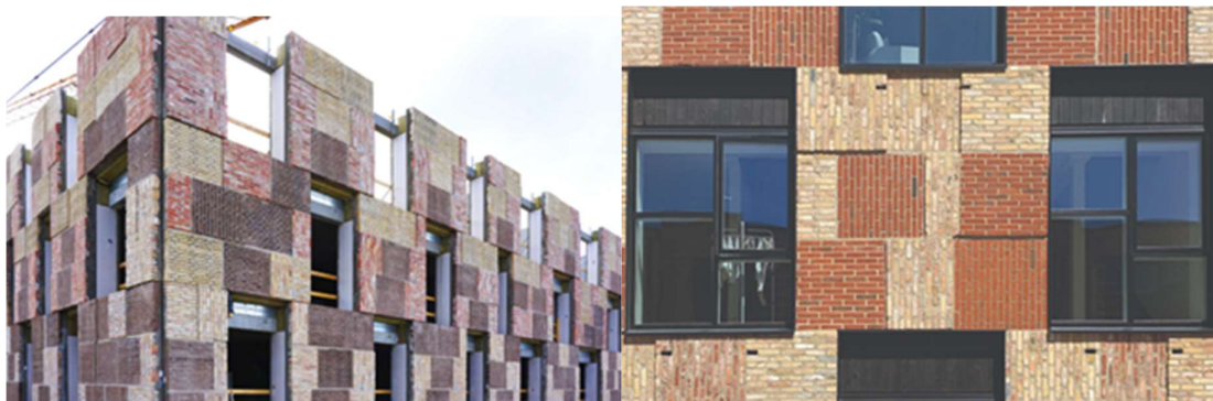
Foto 2. Tellisvoodri plokid paigaldatuna uue hoone fassaadis 48
