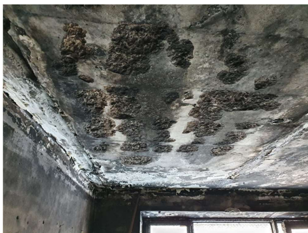
Foto 23. Põlengutunnustega õõnespaneelide alumine pind (I korrus korter 4)
