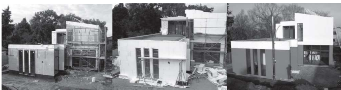
Foto 7. Hoone karkassi montaaž (vasakul); hoone karkass monteerituna (keskel); valmis hoone (paremal) 50
